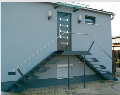
Treppe mit frei auskragenden Trittstufen und Edelstahlhandlauf am eigenen Bürogebäude
